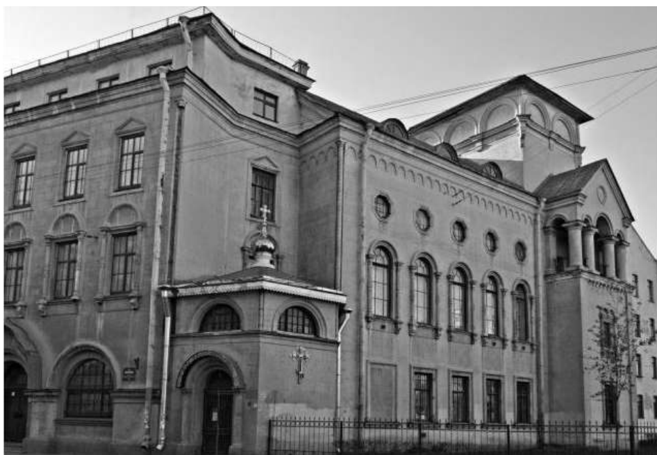
Здание приюта с часовней и храмом, построенное в 1915 г. на ул.Воскова дом 1 (бывш. Бол. Белозерской)
