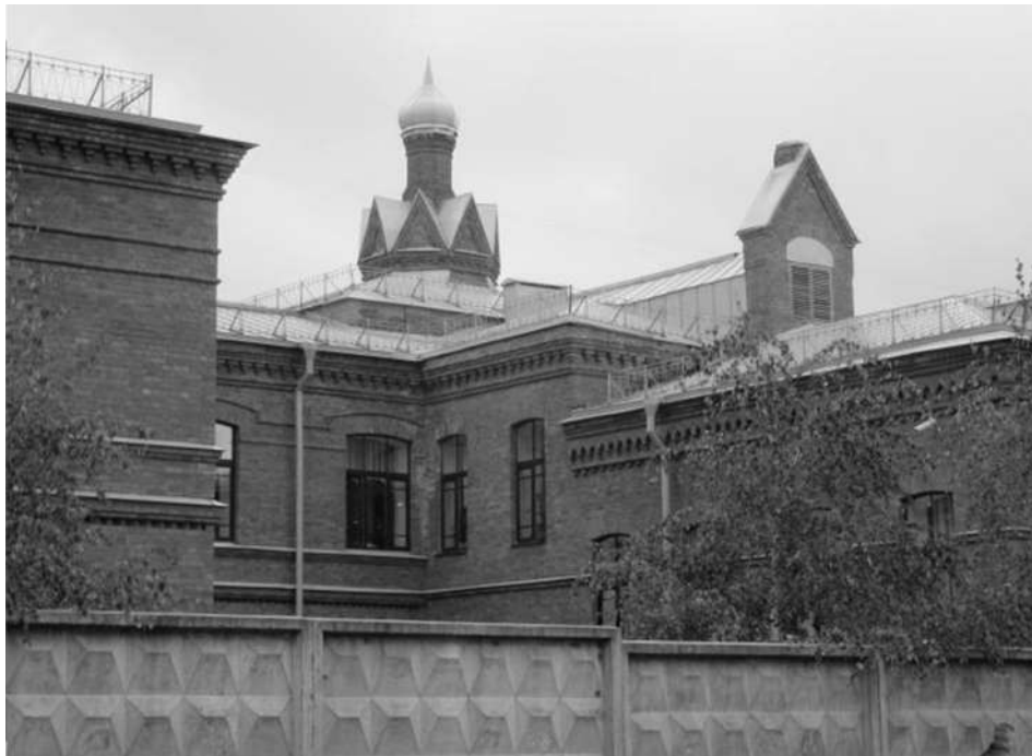
Здание где находился Мариинский приют для детей-калек и умственно-отсталых с церковью Божией Матери «Утоли мои печали» ул. Аккуратова (быв. Мариинская), дом 11
